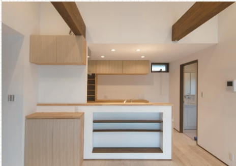
2階のリビングは勾配天井に大きな梁が表れております
